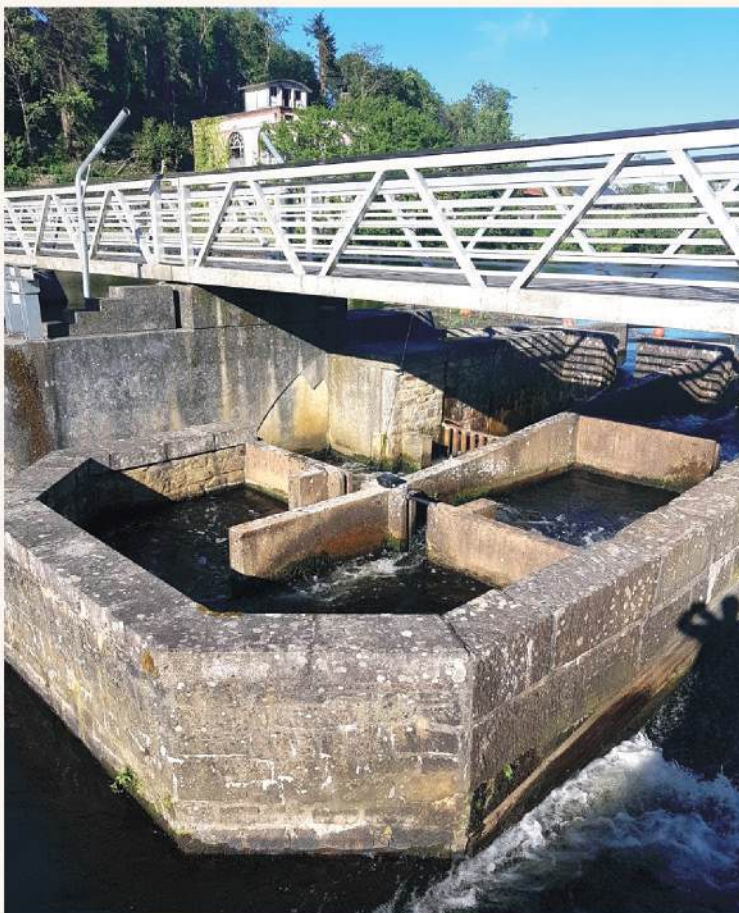
L'une des passes à poissons équipée d'un dispositif de suivi, ici celle de Grand-Barrage sur le Blavet.
